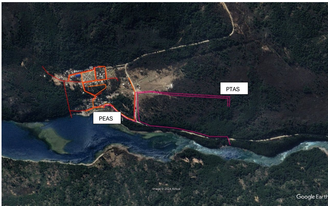
Ilustración 1. Proyecto en ejecución en Puerto Bertrand
